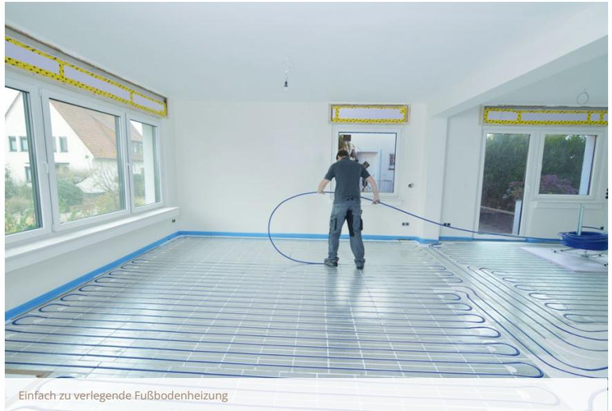
Einfach zu verlegende Fußbodenheizung
