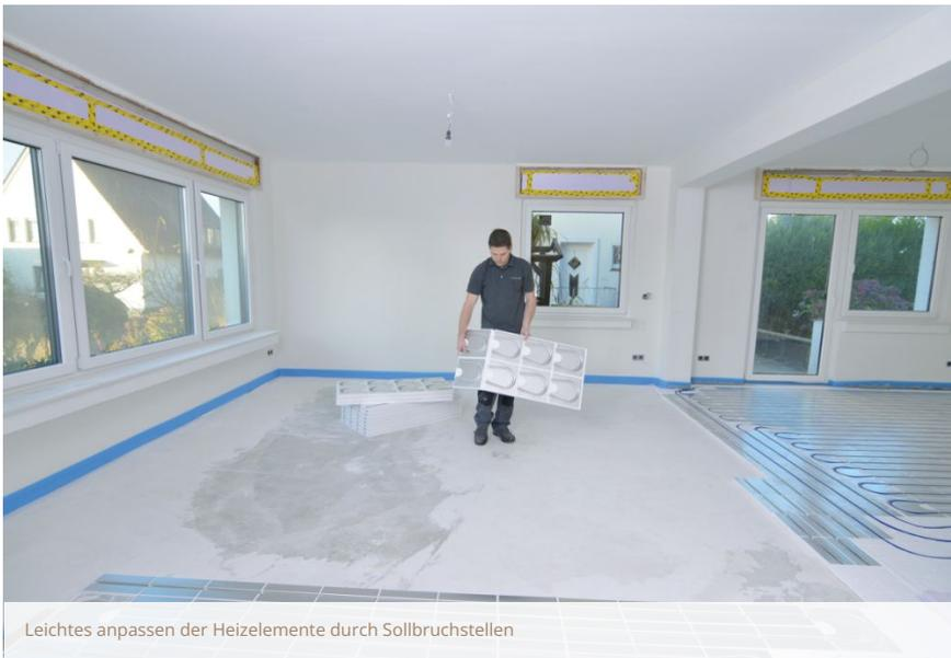
Leichtes anpassen der Heizelemente durch Sollbruchstellen
