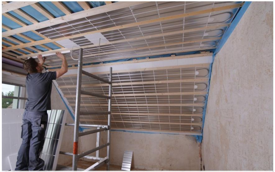
Stabiler Aufbau mittels Zwischenlattung im Trockenbau
