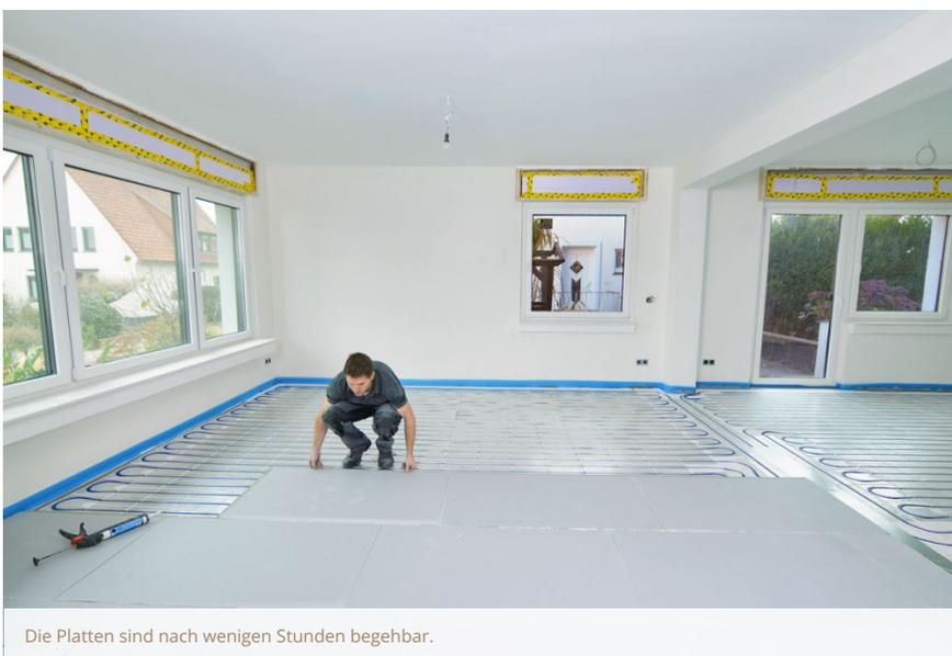
Die Platten sind nach wenigen Stunden begehbar.
