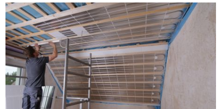
Stabiler Aufbau mittels Zwischenlattung im Trockenbau
