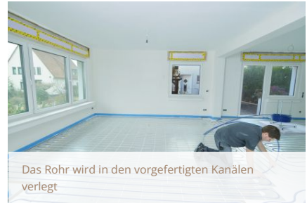
Gleichmäßige Abstände ermöglichen die optimale Nutzung der Fläche für eine wirkungsvolle Flächenheizung
