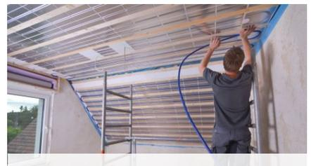
Die Omega-Rohrkanäle halten das Rohr an der Decke
