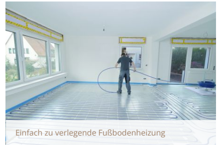
Das Rohr wird in den vorgefertigten Kanälen verlegt
