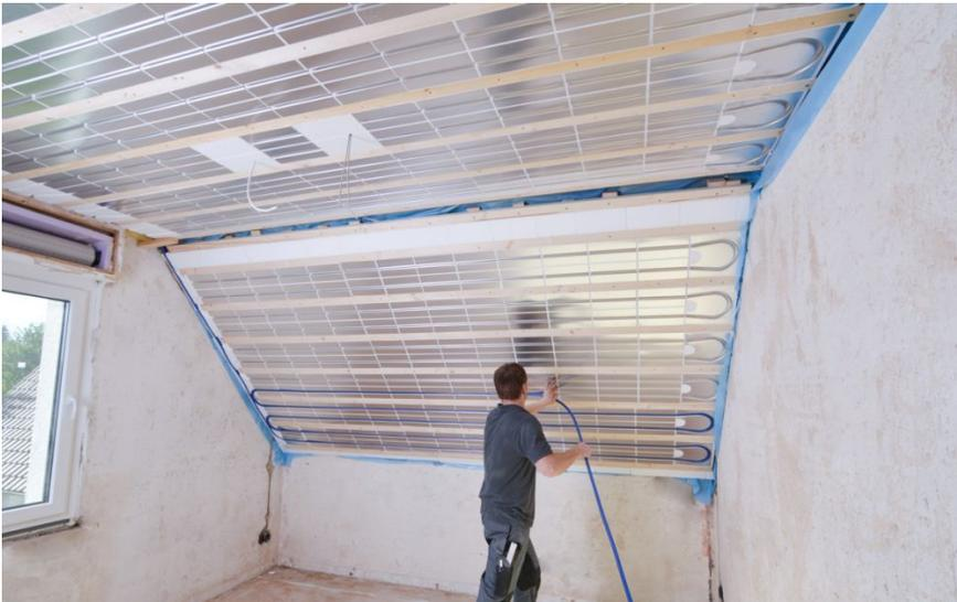
Geradlinige Verlegung des Systemrohrs durch Rohrführungen der Heizelemente.
