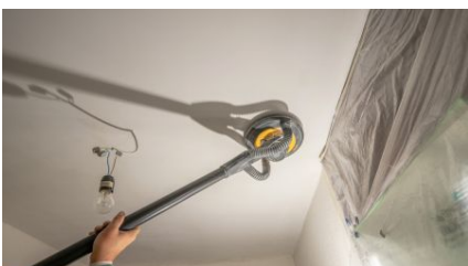
Die gespachtelte Decke wurde glatt geschliffen.
