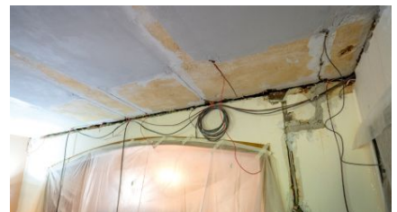
Das FLEECE wurde mit Feinspachtel eingespachtelt.
