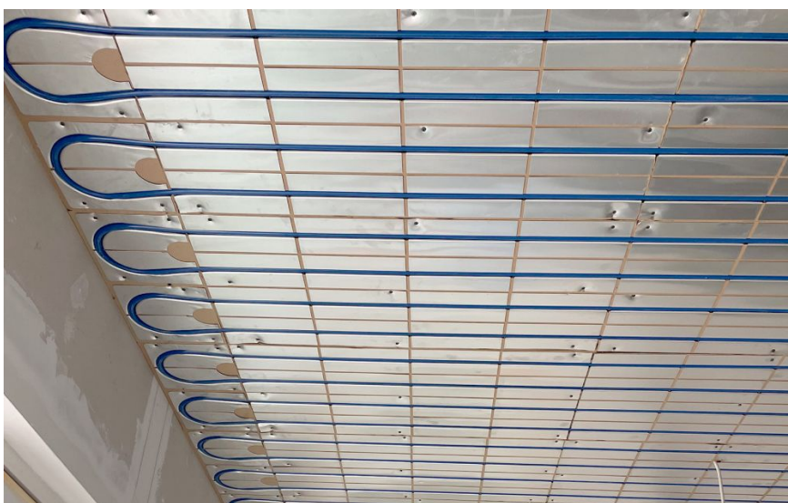
Gleichmäßige Wärmeverteilung durch Aluminiumleitbleche
