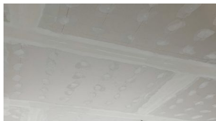
Trockenbauplatten sind in der Fläche verspachtelt
