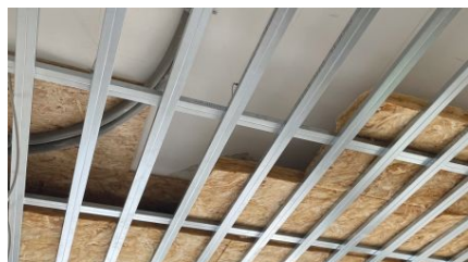
Unterkonstruktion mit C-Profilen
