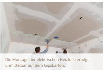
Die Montage der elektrischen Heizfolie erfolgt unmittelbar auf dem Gipskarton.
