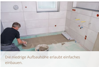
Der unmittelbare Kontakt zur Fliese ermöglicht ein schnelles und effizientes Aufheizen des Bodens.
