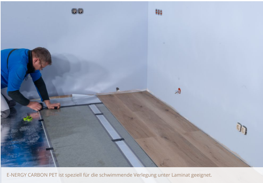
Eine Alukaschierte-Dämmbahn bildet den Unterbau.
