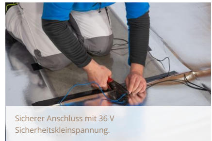
Die Folienbeschichtung macht es robust gegen Abrieb.
