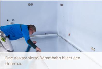
Eine Alukaschierte-Dämmbahn bildet den Unterbau.
