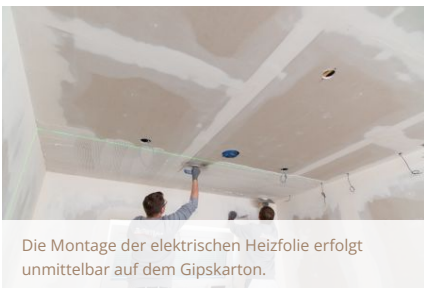
Dank Perforation durchdringt die Spachtelmasse das Fleece leicht.
