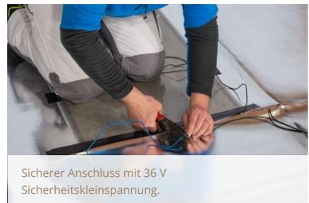
Sicherer Anschluss mit 36 V Sicherheitskleinspannung.
