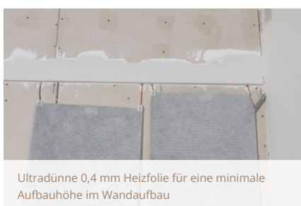
Unsichtbarer Komfort: Montage der E-ENERGY CARBON FLEECE Heizfolie direkt an der Wand des Aufenthaltsraums
