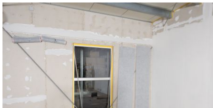
Die Heizfolie E-ENERGY CARBON FLEECE verschwindet vollkommen in der Spachtelschicht
