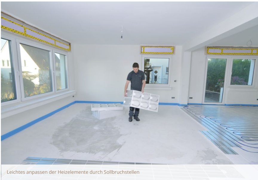
Gleichmäßige Abstände ermöglichen die optimale Nutzung der Fläche für eine wirkungsvolle Flächenheizung
