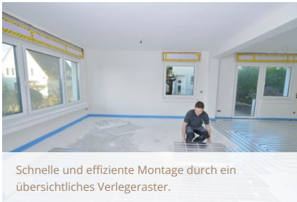
Leichtes anpassen der Heizelemente durch Sollbruchstellen
