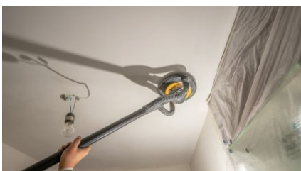
Die gespachtelte Decke wurde glatt geschliffen.
