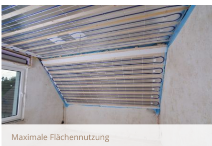
Geradlinige Verlegung des Systemrohrs durch Rohrführungen der Heizelemente.
