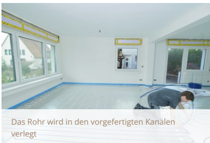
Schnelle und effiziente Montage durch ein übersichtliches Verlegeraster.
