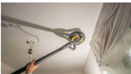
Die gespachtelte Decke wurde glatt geschliffen.
