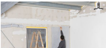
Unsichtbarer Komfort: Montage der E-ENERGY CARBON FLEECE Heizfolie direkt an der Wand des Aufenthaltsraums
