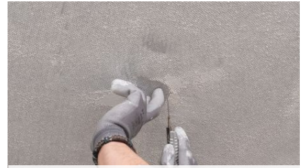
Löcher für Spots können ausgeschnitten werden.
