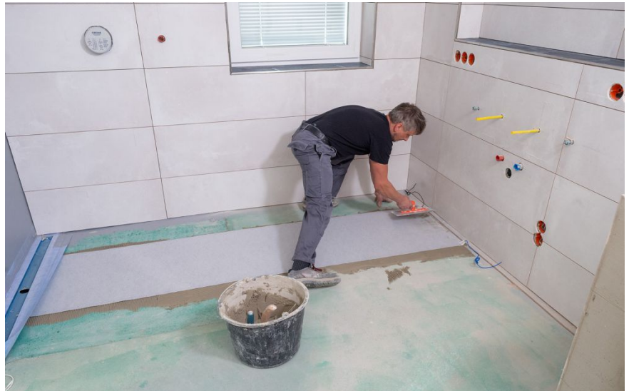
Der unmittelbare Kontakt zur Fliese ermöglicht ein schnelles und effizientes Aufheizen des Bodens.
