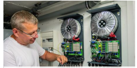
Systemeigene Netzteile für den effizienten Betrieb mit 36 V Sicherheitskleinspannung (SELV)
