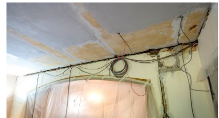
Das FLEECE wurde mit Feinspachtel eingespachtelt.
