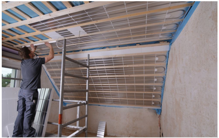
Stabiler Aufbau mittels Zwischenlattung im Trockenbau
