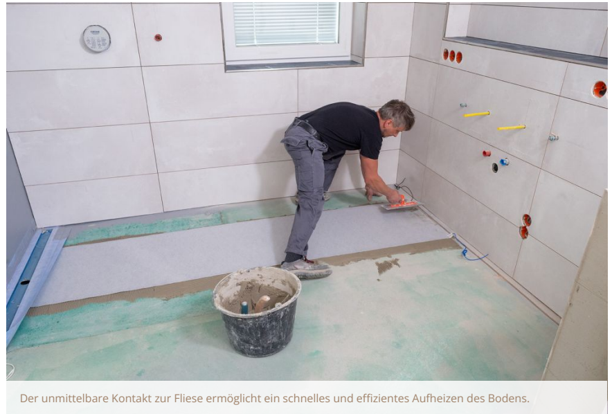
Die Heizfolie ist diffusionsoffen und haftungsoptimiert.
