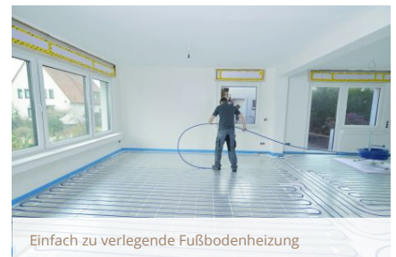
Das Rohr wird in den vorgefertigten Kanälen verlegt
