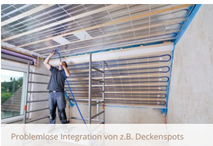
Geradlinige Verlegung des Systemrohrs durch Rohrführungen der Heizelemente.
