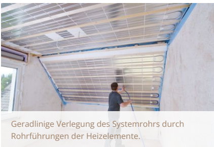
Stabiler Aufbau mittels Zwischenlattung im Trockenbau
