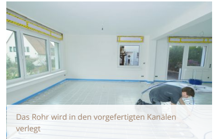
Gleichmäßige Abstände ermöglichen die optimale Nutzung der Fläche für eine wirkungsvolle Flächenheizung
