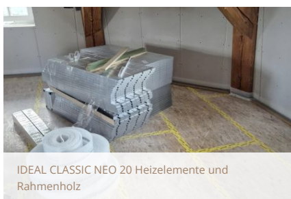
Optimale Wärmeverteilung über Aluminium Wärmeleitbleche
