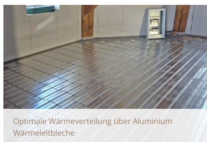
Schneller Baufortschritt durch einheitliches Verlegeraster der Heizelemente
